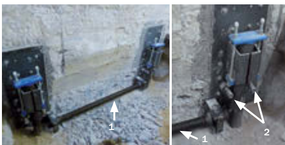
Figura 10. Conjunto de aparatos de recalce en el lado del edificio existente. En las fotos se aprecia tanto la conexión, mediante el tirante, de los dos aparatos instalados en cada lado del muro (1), como los pasantes que conectaban las parejas de aparatos situados a cada lado del muro (2).
