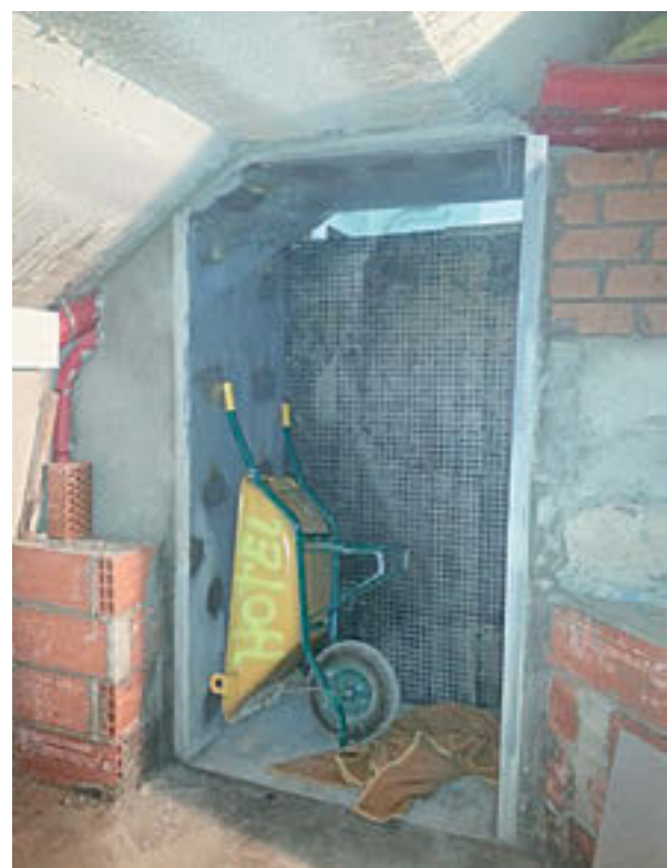
Figura 12. Vista final tras el enmarcado del hueco.
