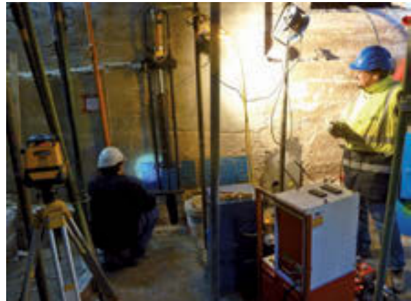
Figura 5. Hincas hidráulicas de perfiles con control mediante nivelación láser.
