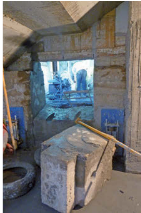
Figura 11. Huelco parcial realizado mediante equipo de corte de hilo de diamante. Se aprecia un primer bloque de hormigón. Vista desde el lado de la ampliación.
